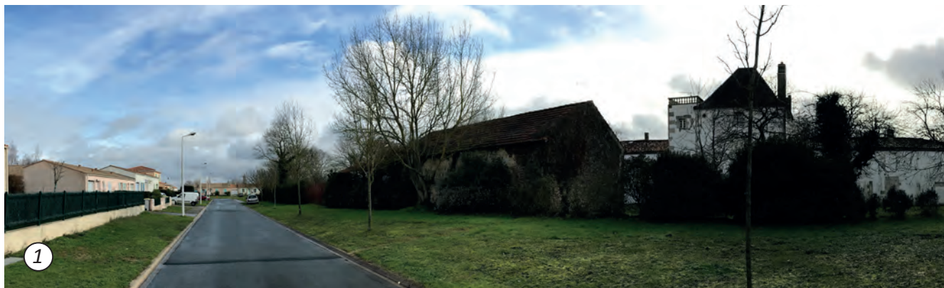
Vue depuis la rue Saint-Sylvestre sur le logis. La volumétrie du bâtiment se différencie singulièrement des maisons pavillonnaires voisines et apporte de la diversité.
