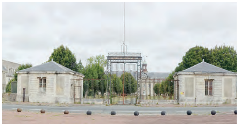
Le portail d'entrée et ses pavillons
