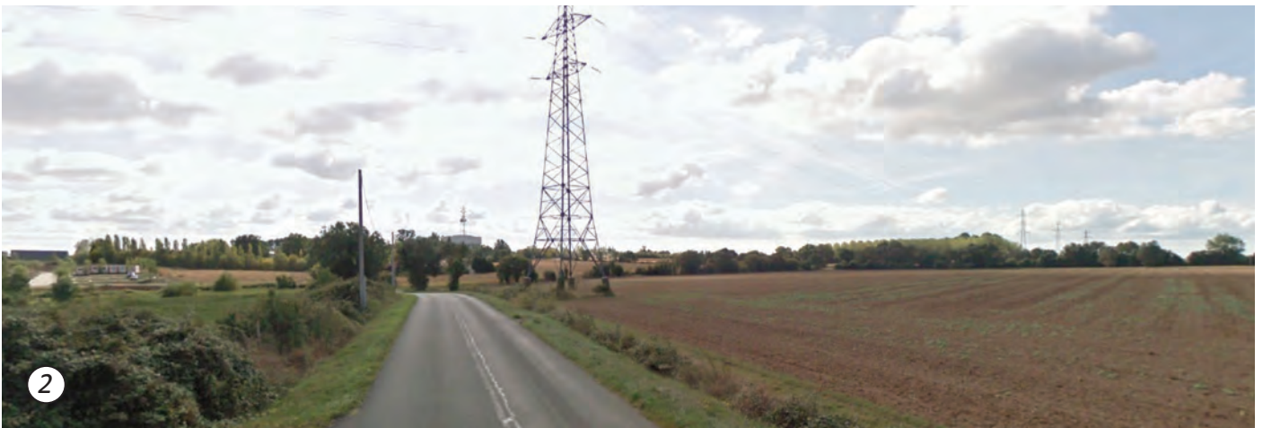
Vue vers le Sud depuis la Route de Breuil. Le projet se situe à droite de la chaussée. Le vallonnement du relief implique la prise en compte nécessaire de l'écoulement naturel des eaux pluviales dans l'organisation des opérations futures.
