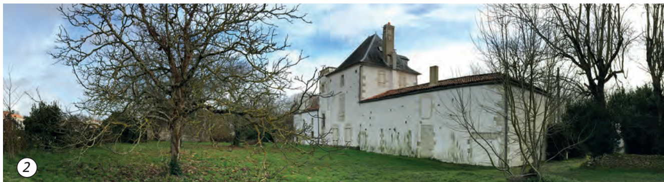
Vue sur la façade Nord du logis et son jardin jouxtant la rue Saint-Sylvestre.
