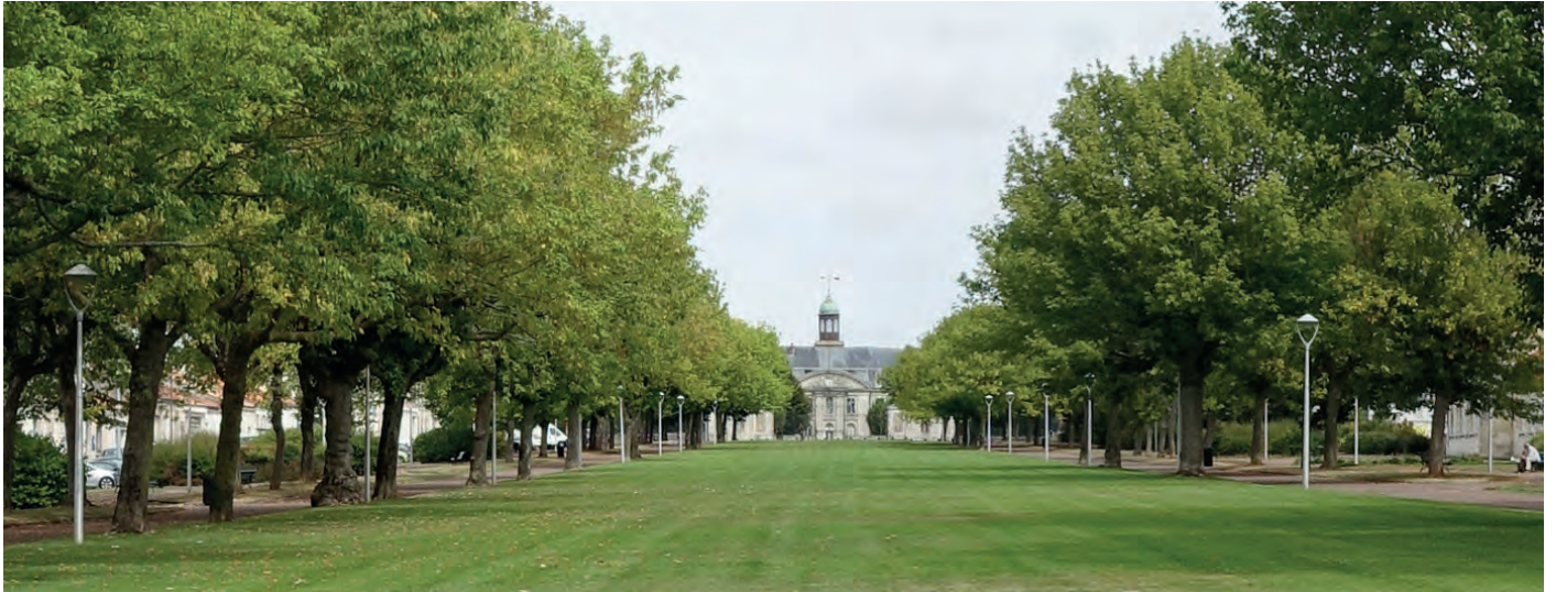
Vue de la façade nord et du jardin historique
