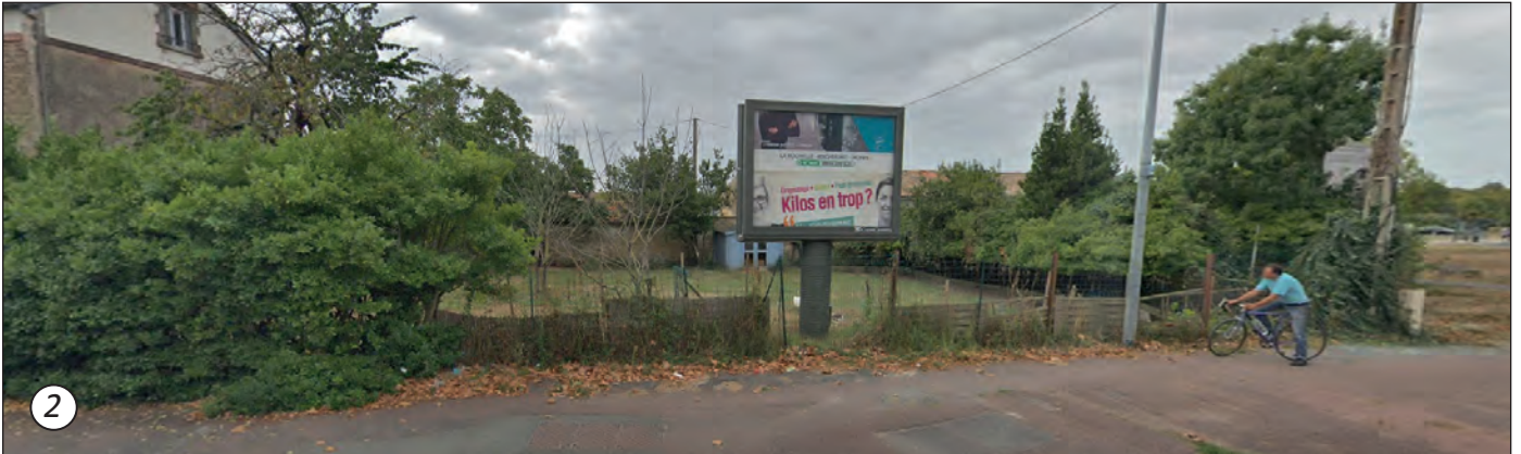
2 Vue de la façade existante depuis le boulevard de la Résistance
