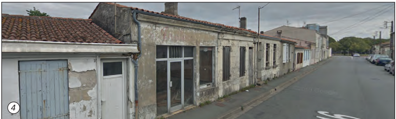
4 Vue depuis la rue Pasteur à l'endroit où se situe l'emplacement réservé pour le prolongement sud de la rue de l'amiral Meyer.
