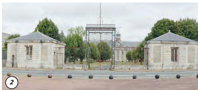
Le portail d'entrée et ses pavillons
